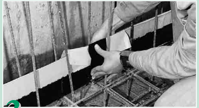
1 Entfernen der unteren Schutzfolie
