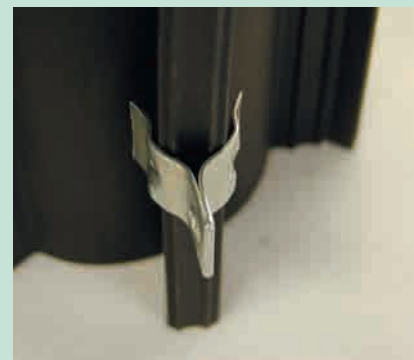
Befestigung mittels Fugenbandklammer
