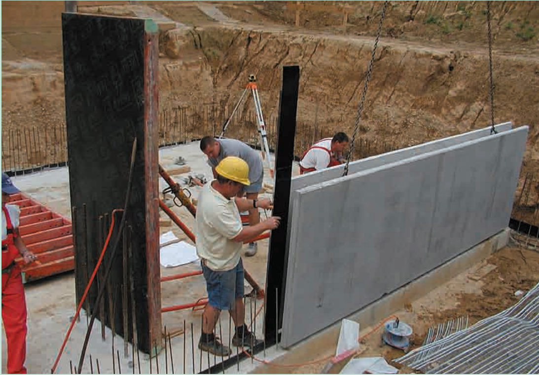
Das Sollrissfugenprofil Gerade wird montiert.
