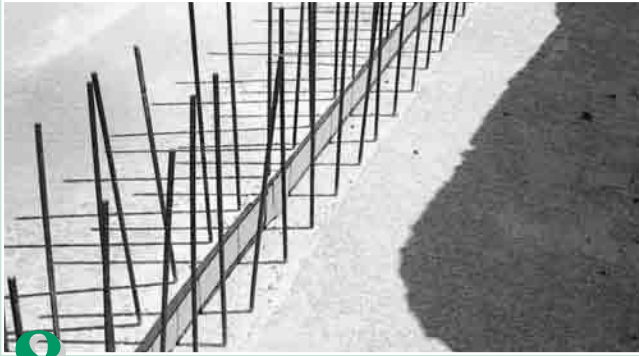
8 MASTER-Dichtblech im eingebauten Zustand Betondeckung 3 cm
