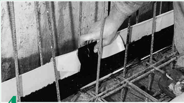
2 Aufstellen des Elementes auf die oberste Armierungslage
