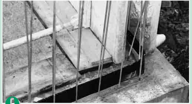
9 MASTER-Dichtblech im Bereich zweischaliger Wunde
