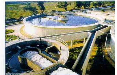
Wasseraufbereitungs- und Kläranlagen Shebin el Koum Kläranlage, Kairo, Ägypten
