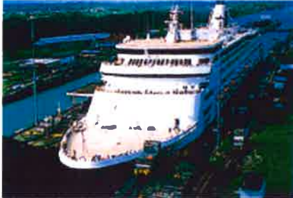
Abdichtung von Schleusenanlagen und Betonkanälen Panamakanal, Panama
