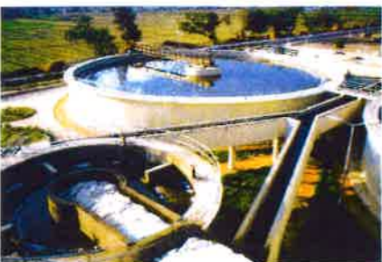
Betonabdichtung Wasseraufbereitungs- und Kläranlagen Shebin el Koum Kairo, Ägypten
