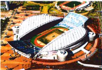
Abdichtung von Betonbauteilen Olympiastadion Sydney, Australien
