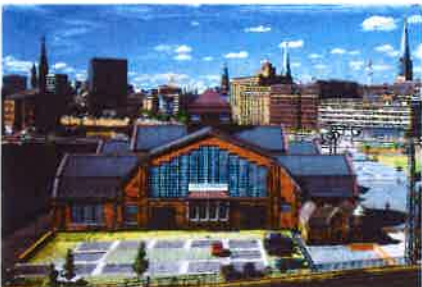
Beton- und Mauerwerksabdichtung Deichtorhallen, Hamburg
