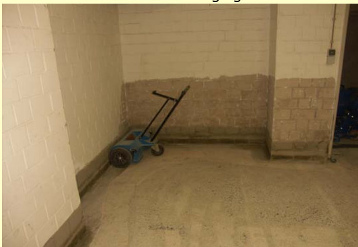
Freigelegte und kugelgestrahlte Bodenplatte
