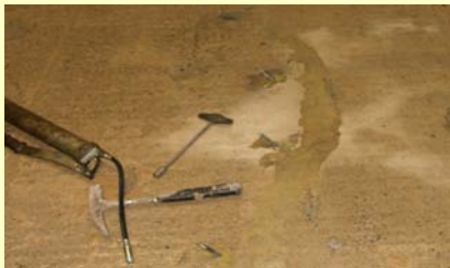
PUR-Injektion zur Rissabdichtung
