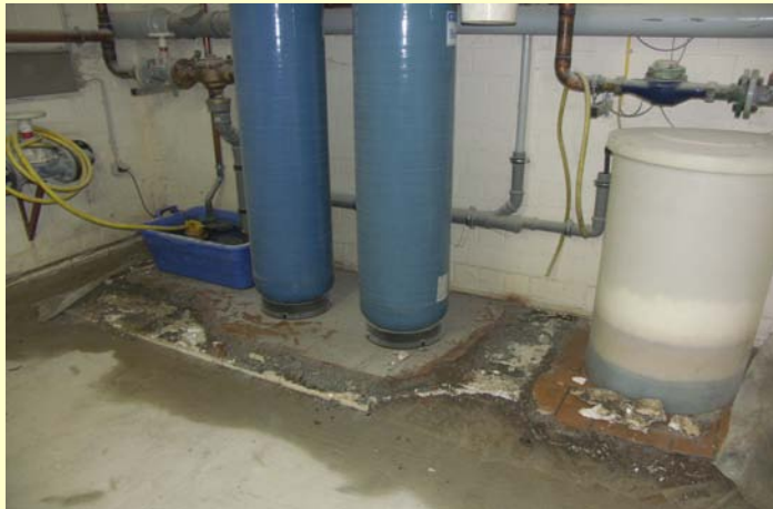
Teilentfernter Fußbodenaufbau
