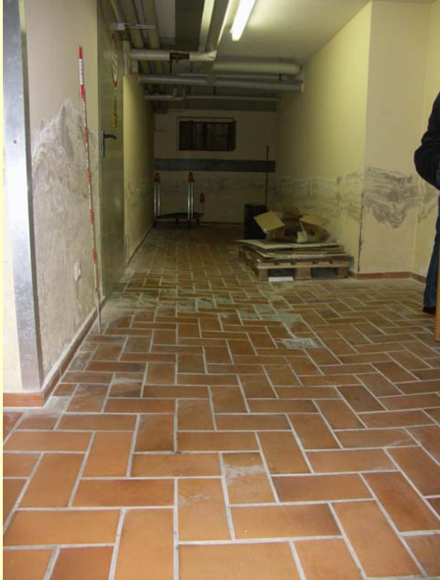
Typische Feuchteschäden
