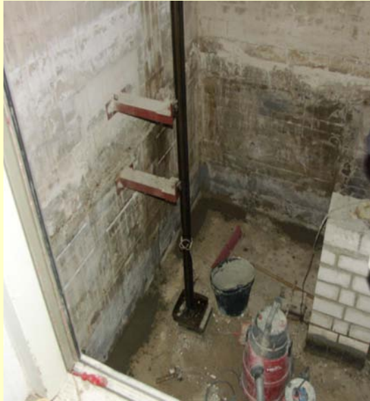
Schacht nach Estrich Rückbau
