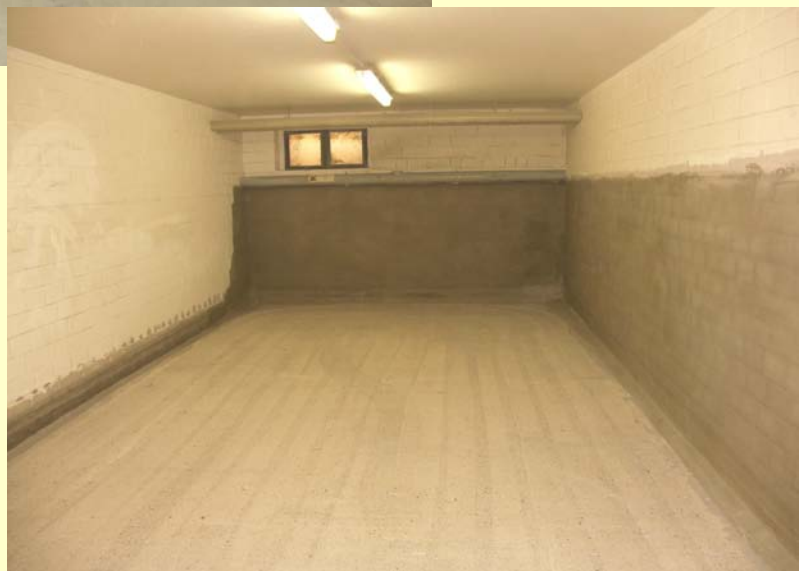
Druckwasserdichte Dichtschlämme als Negativabdichtung der Umfassungswände
