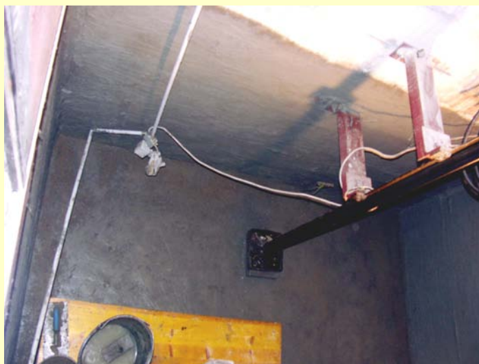
Einbringung von 8 cm Sperrestrich im Verbund
