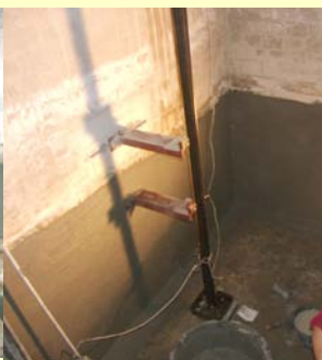
Dichtschlämmenauftrag
