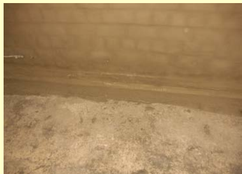
Fußpunktabdichtung mit Hohlkehle
