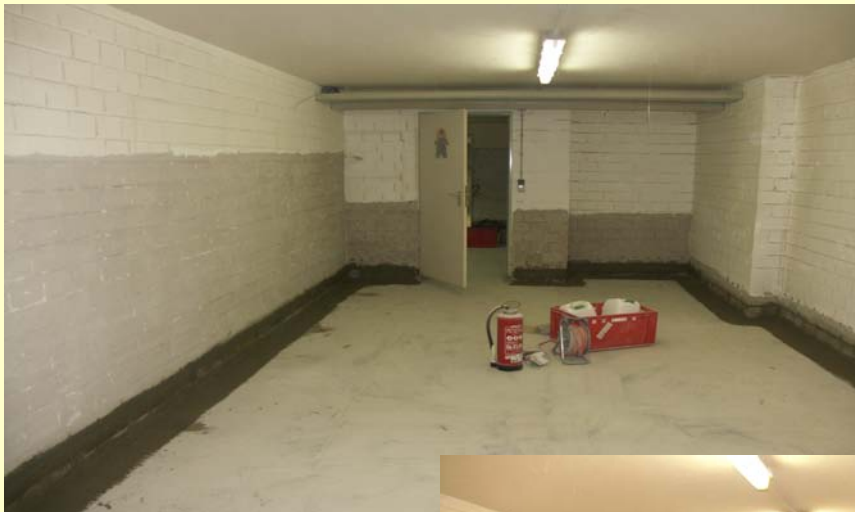
Umlaufende Fußpunkt: Hydrophobierung
