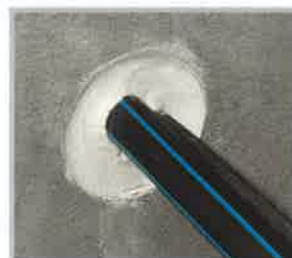
Abspachteln der Dichtmasse
