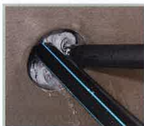
Füllen des Ringspaltes
