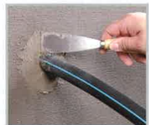
Verspachteln mit Schnellzement
