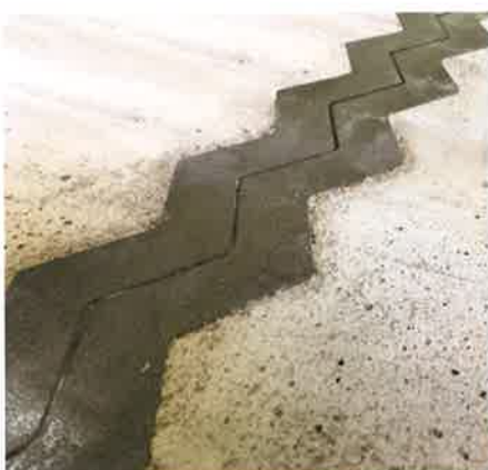
Fuge nach dem Betonieren
