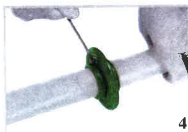
4 Festes Anziehen der beiden Spannbänder von Hand
